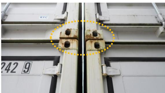
(写真2①) コンテナ同士の固定
