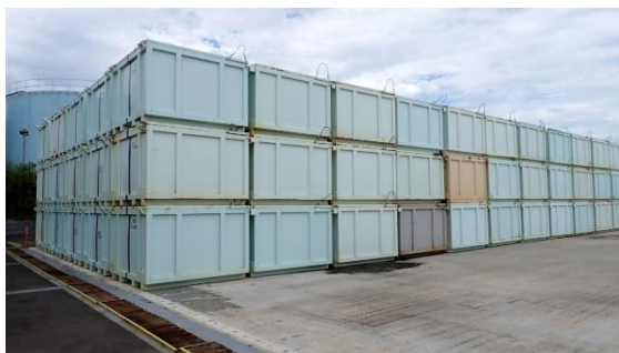
(写真1①) 保管状況 (東側)
