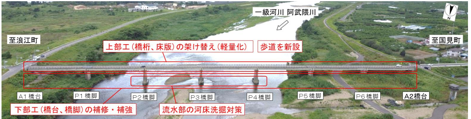
伊達崎橋の復旧方針
