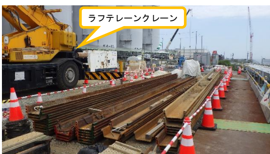
(写真2-1) K4タンクエリア南側の状況①
