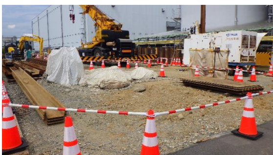
(写真2-2) K4タンクエリア南側の状況②
