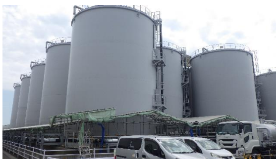
(写真1-1) K4タンクエリアの外観 (北西側から撮影)
