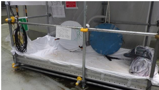
(写真4-1) 装備着脱用のハウス設置中の状況 (C9タンク)
