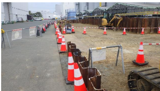
(写真1-3) K4タンクエリア南西側の状況
