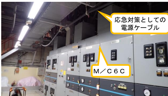
(写真1-1) M/C6Cへの電源ケーブルの敷設状況① 6号機複合建屋内 (応急対策)
