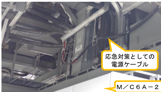
(写真1-4) M/C6A-2への電源ケーブルの敷設状況② 5号機タービン建屋内 (応急対策)
