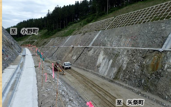
【R6施工状況（掘削が概ね完了）】
