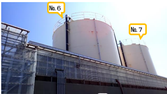
(写真1-3) 集水タンクNo.6~7 (3号機タービン建屋東側) (北西側から撮影)
