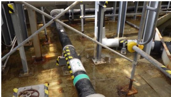
(写真 2 - 2) 集水タンク堰内の状況
