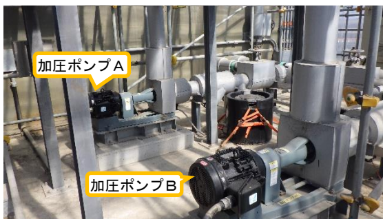
(写真 3) 加圧ポンプ及び移送配管の設置状況
