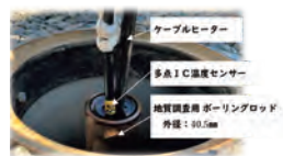
写真1. テスト孔による実証試験
