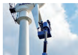
・高所作業車を使用したブレード改造工事
