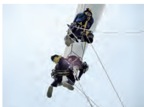
・ロープワークによるブレード点検
