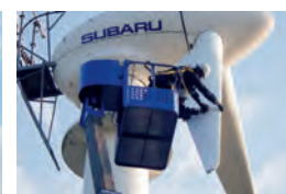
・高所作業車を使用したブレード改造工事
