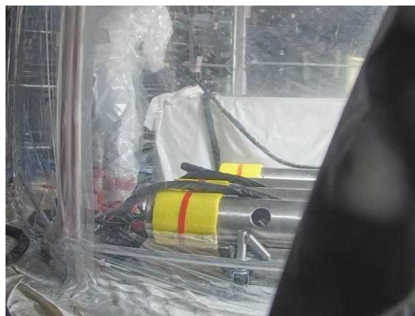
押し込みパイプへケーブル入線作業を実施 (2024年7月28日)
