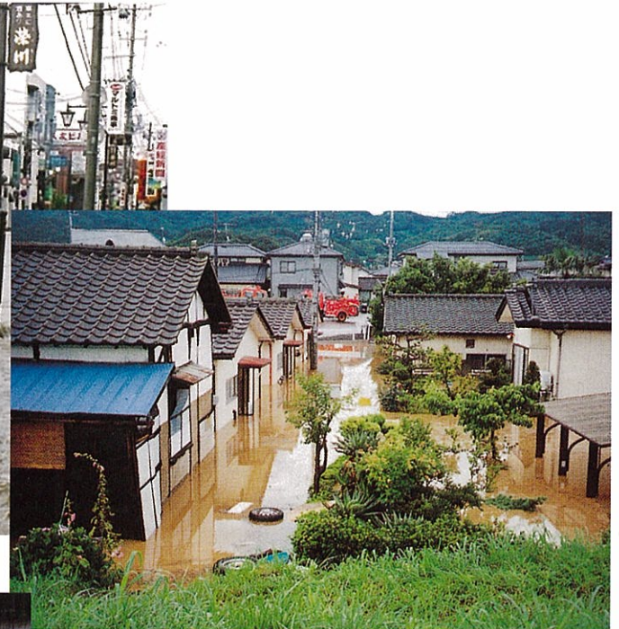
平成14年【台風6号】福島市内の浸水状況
