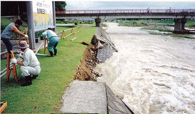
●(一級)宮川筋 会津高田町大字高田地内 (護岸欠壊)
