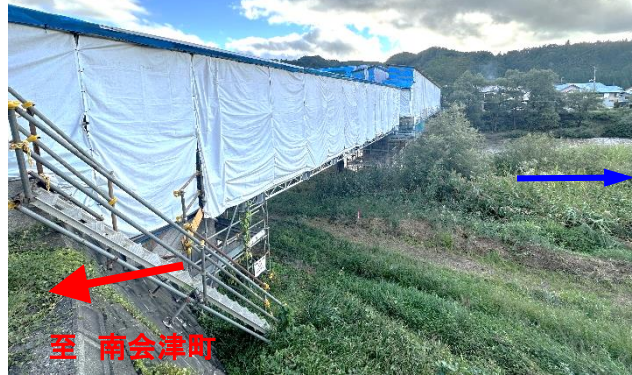
国道289号明和歩道橋 施工状況(R6.9)
