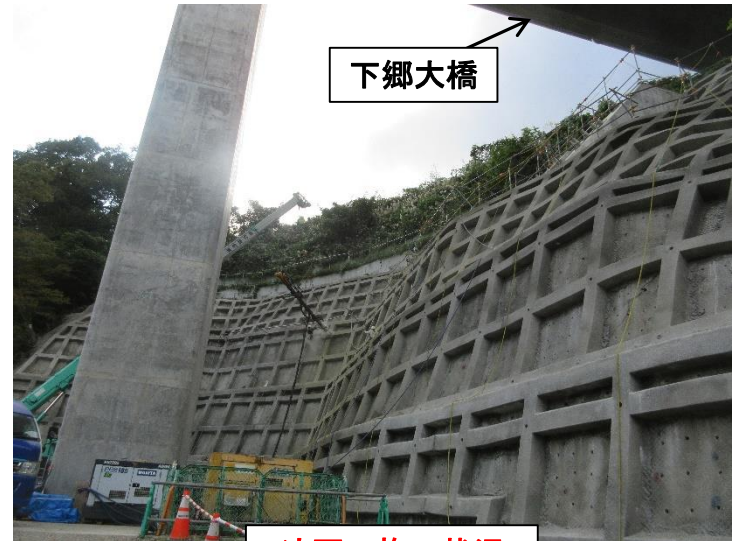
法面工施工状況
