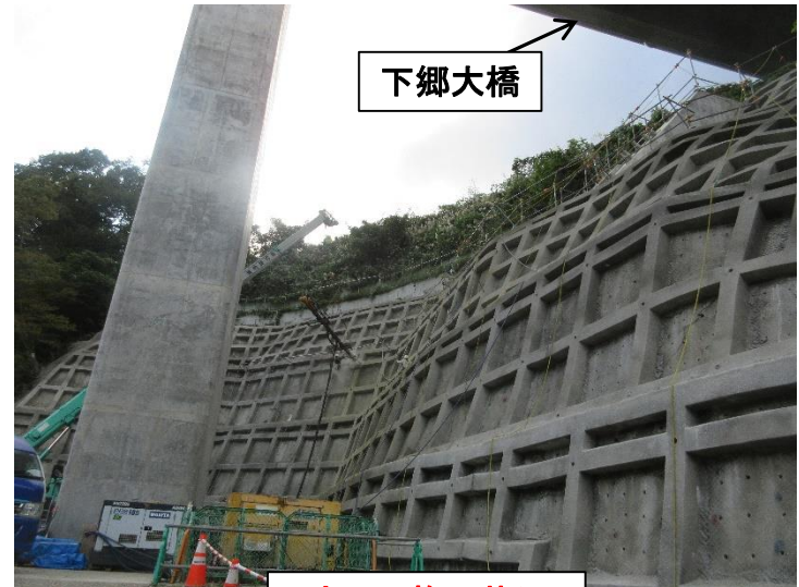
法面工施工状況
