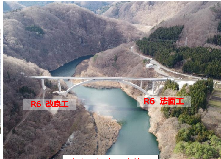
令和6年度工事箇所
