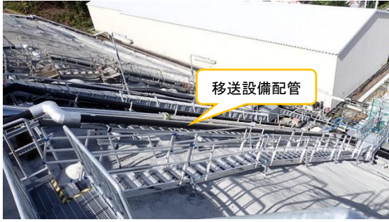
(写真 2 - 2) 移送設備配管の状況②
