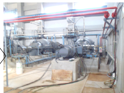
○排水機復旧状況
