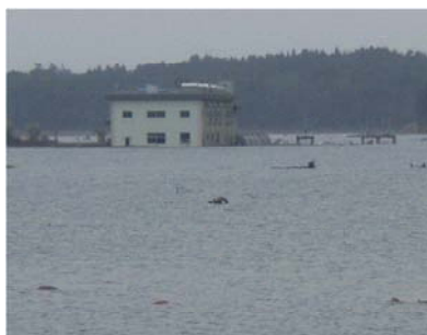
○排水機場周辺浸水状況
