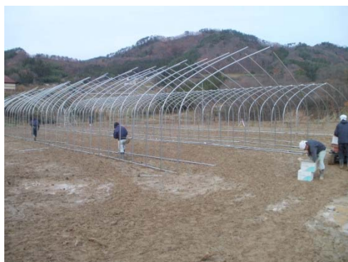
パイプハウスの整備状況
