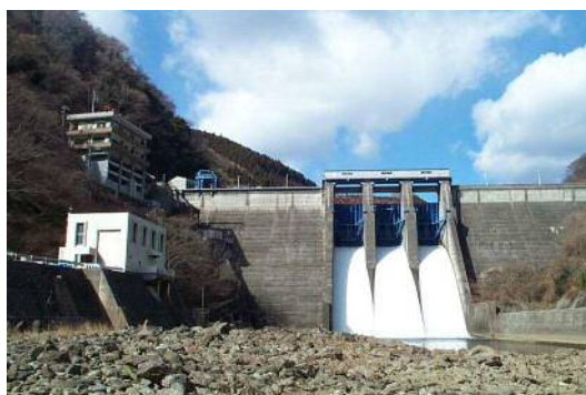
放流中の高柴ダム
