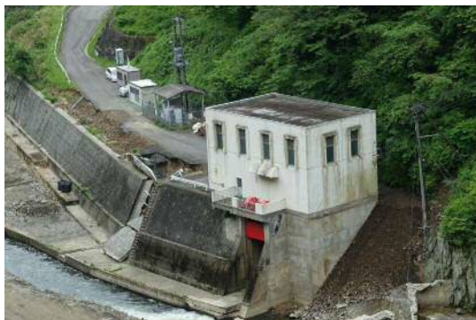
高柴ダム発電所（更新前）
