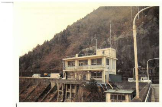
旧・高柴ダム管理事務所庁舎
