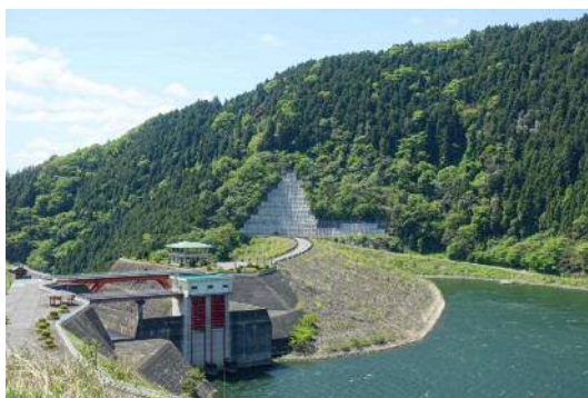
山頂公園より四時ダム堤体を望む
