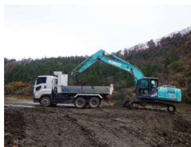
貯水池からの搬出状況
