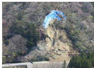
H26. 4. 5法面崩壊 (全面通行止)
