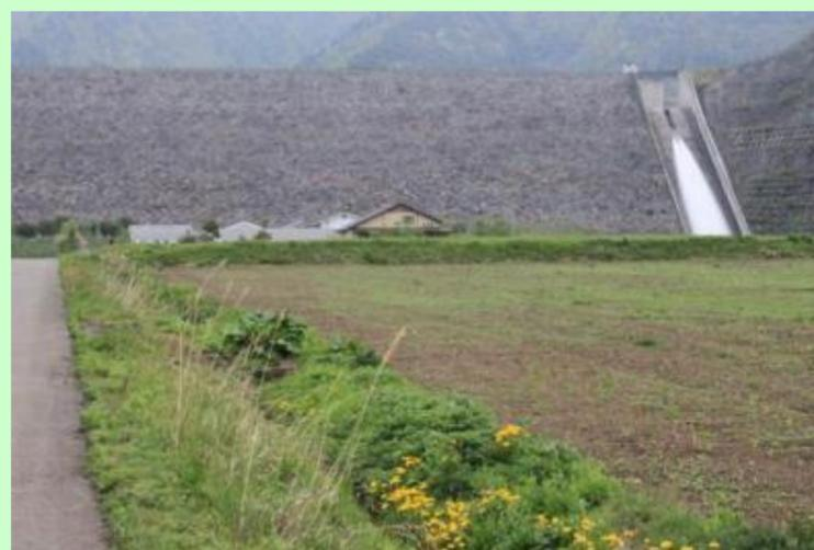
毎年、6月14日から10月31日での期間を「洪水期」として定め、梅雨前線や台風などによる急な出水から、流域の皆さんの暮らしを守るため、ダム湖の貯水位をあらかじめ下げて、ダムの空き容量を大きくして 洪水調節を行うため、放流を行っています。
