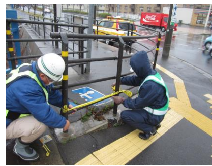
応急補修作業
