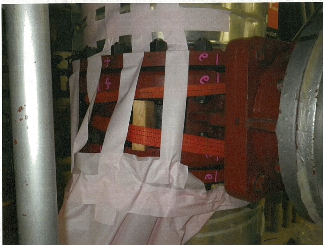
2 仮補修後の配管
