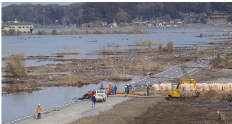
排水機場が動かないため、小型ポンプで海水を排水しました。
