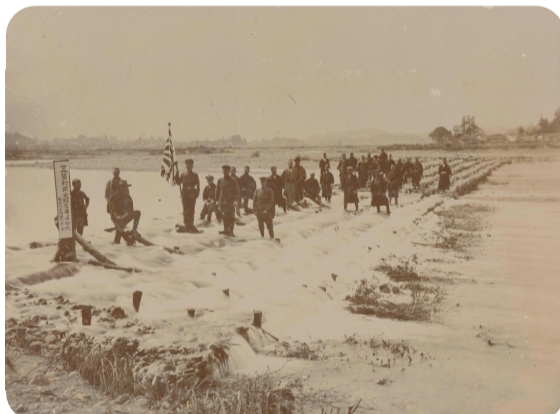
完成した五箇堰の上で撮影（明治時代）
