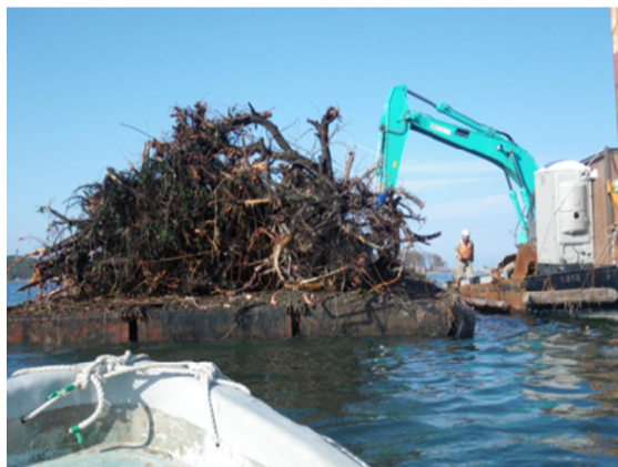
作業船から一つ一つ流木を拾い上げます。
