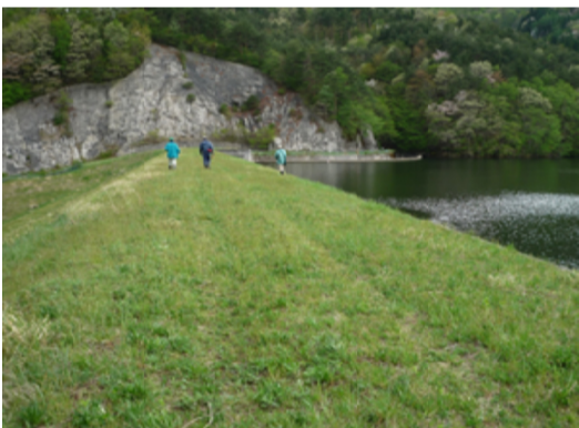
広くて平坦だった地震前の堤体天端。
