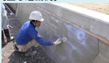
老朽化した水路壁のコーティング
