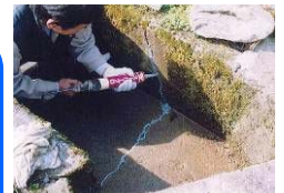
水路のひび割れ補修
