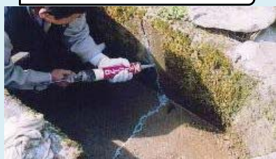
水路のひび割れ補修
