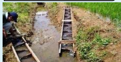
水田魚道の設置
