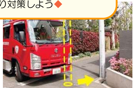
電柱民地移設の例
