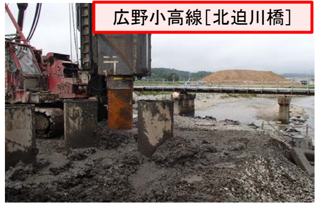
(橋の橋脚をつくっている状況)
