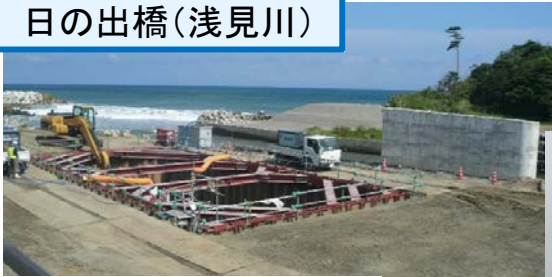
(橋の橋脚をつくっている状況)
