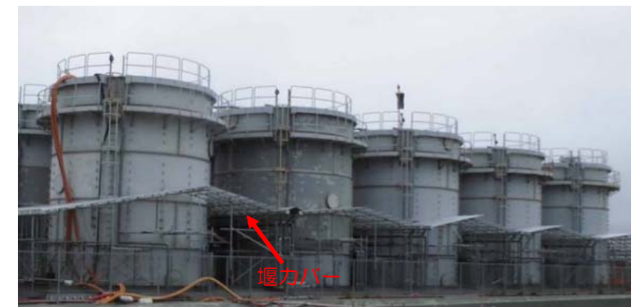
<タンク堰カバー設置 現場状況>
