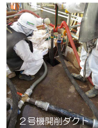
<間詰め充填 現場作業状況>
