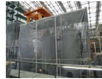
(放射性物質を吸着する設備の設置状況)
