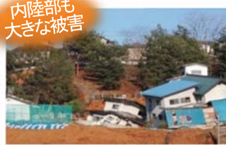
家屋被害の状況（福島市伏拝地区内）
