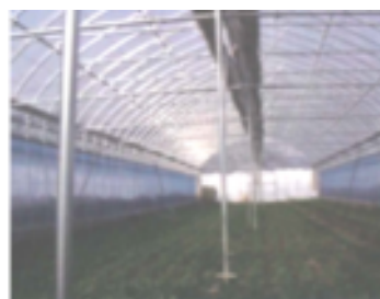
中柱（仮支柱）設置の写真
