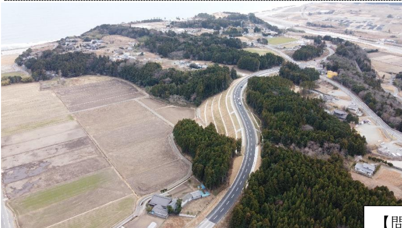
← 井出工区 一部供用開始区間
