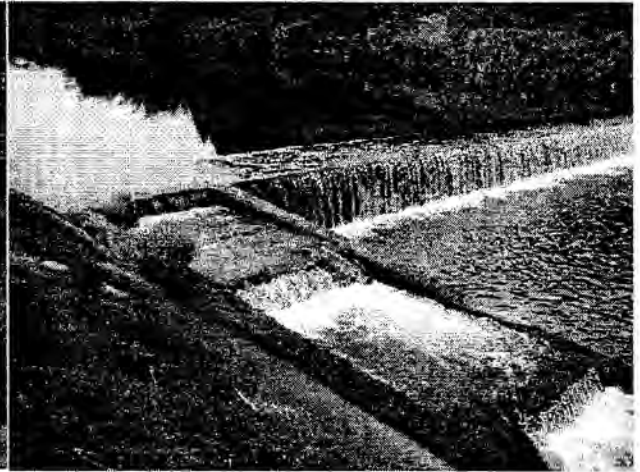
写真2 岡和田堰の魚道
