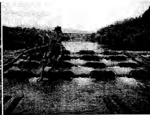
写真4 浮田堰の魚道
