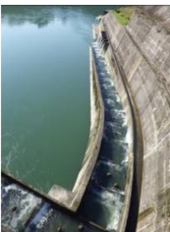
写真30 魚道下流部分
