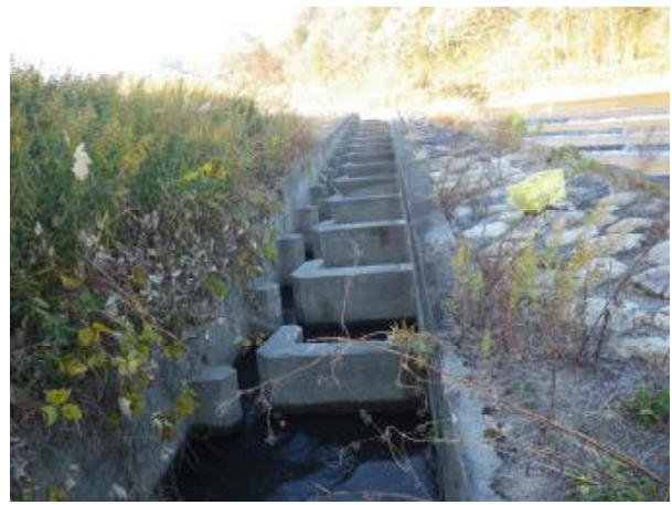
写真17 三島堰の魚道
