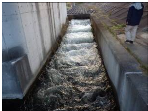
写真11 魚道内部(右岸側)
