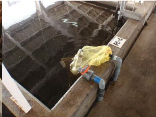
沈殿池注水部
