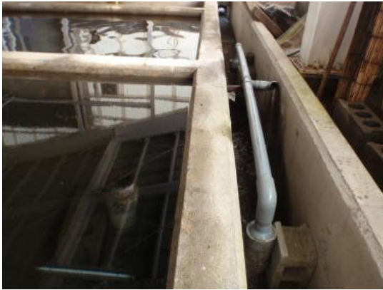
沈殿池排水部
