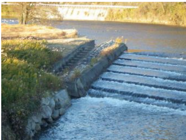
写真16 三島堰の魚道
