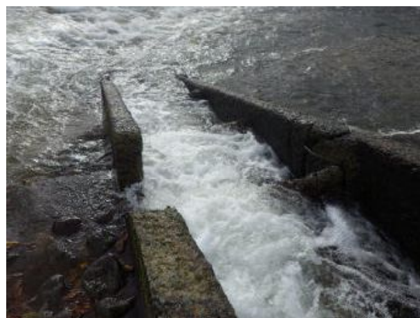
写真 19 塩田堰の魚道
