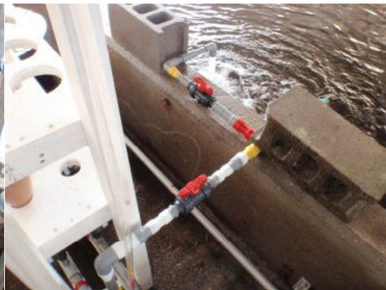
ふ化器取水部配管
