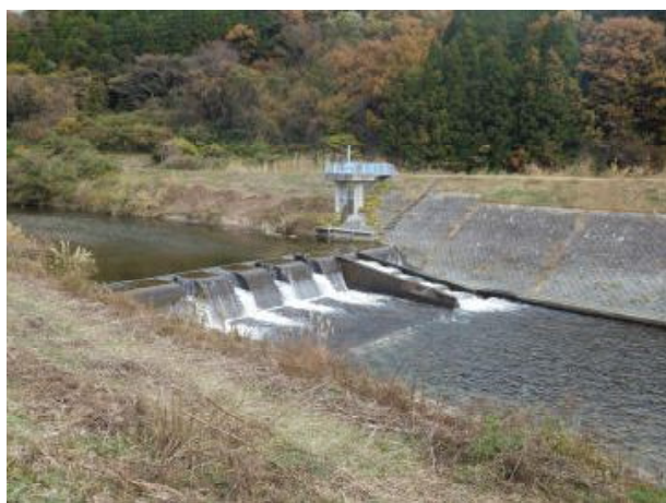
写真22 独古内堰全景
