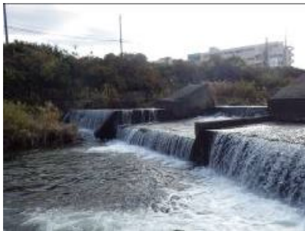
写真24 町田橋上の堰堤
