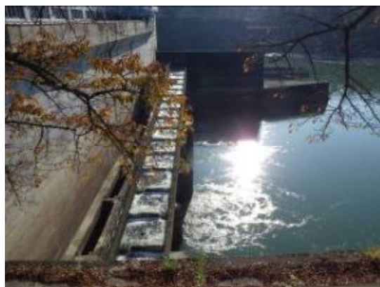
写真29 魚道中央部分
