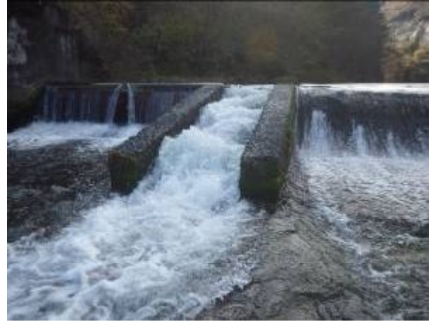
写真13 魚道内部の状況
