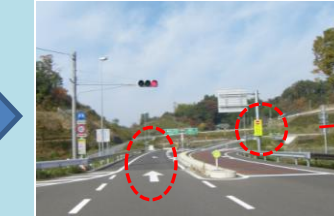
石川母畑ICで実施した逆走防止対策(路面標示と進入禁止看板の追加設置)
