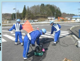
舗装の穴ぼこ補修状況
