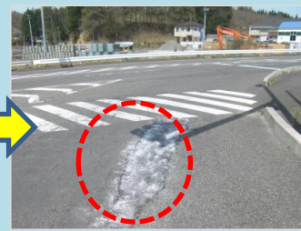
舗装の穴ぼこ補修完了
