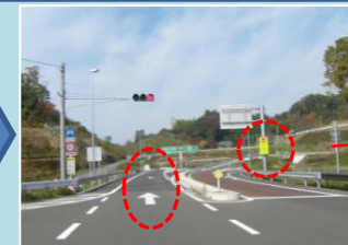
石川母畑ICで実施した逆走防止対策(路面標示と進入禁止看板の追加設置)
