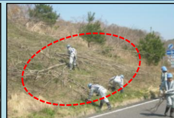
支障木処理作業状況
