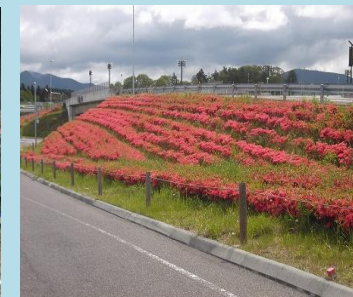
現在の小野IC周辺状況
