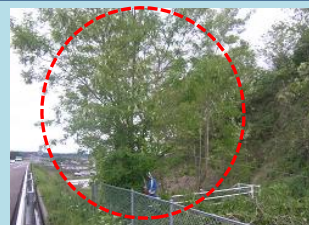
支障立木の伐採前状況
