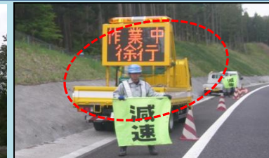
支障木処理作業中安全状況
