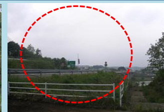
支障立木の伐採後状況
