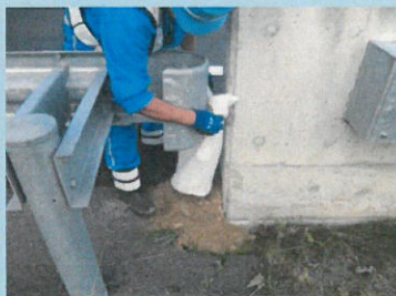
路肩補修作業
