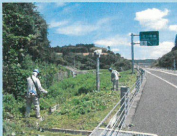
道路除草作業
