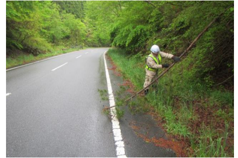
支障木撤去作業
