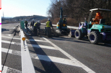
あぶくま高原道路の緊急復旧作業状況
