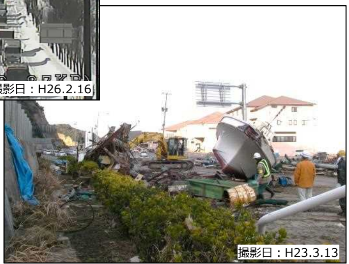
▼国道6号津波による被災状況 (いわき市)
