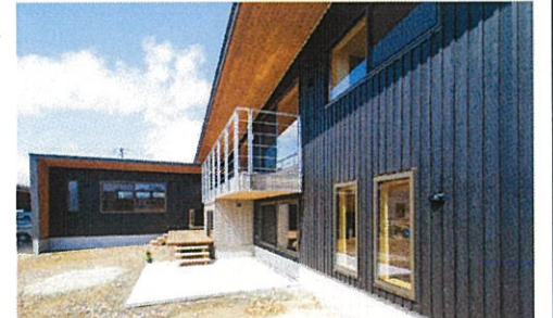
部分的に交換可能な杉板目板張りの外壁
