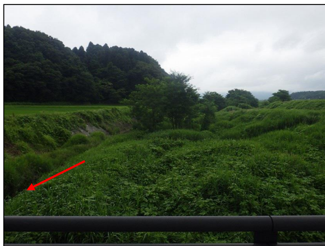
工事前の様子
