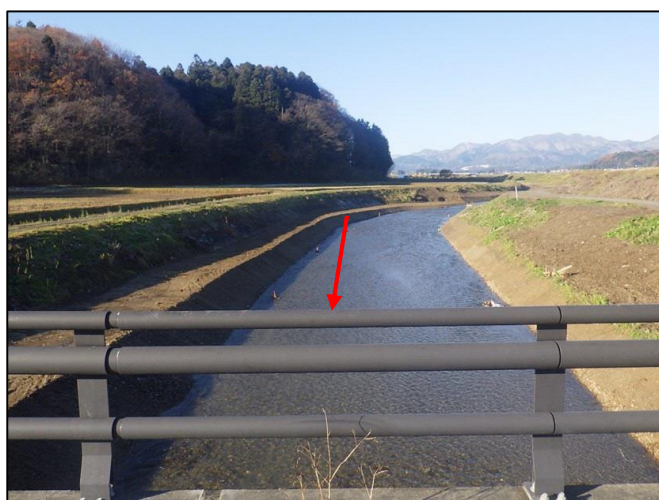
工事後の様子
