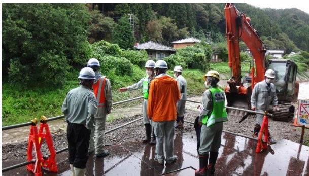
点検状況<須賀川、石川方面>
