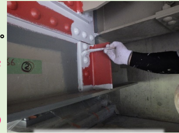
R1塗装塗替え状況
