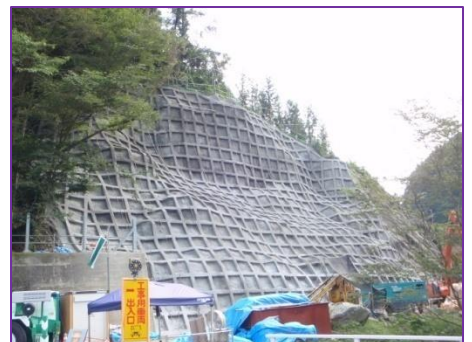
終点側現場打込砕工施工完了
