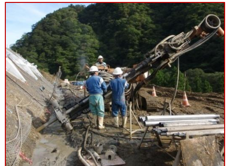
グラウトアカー工施工状況
