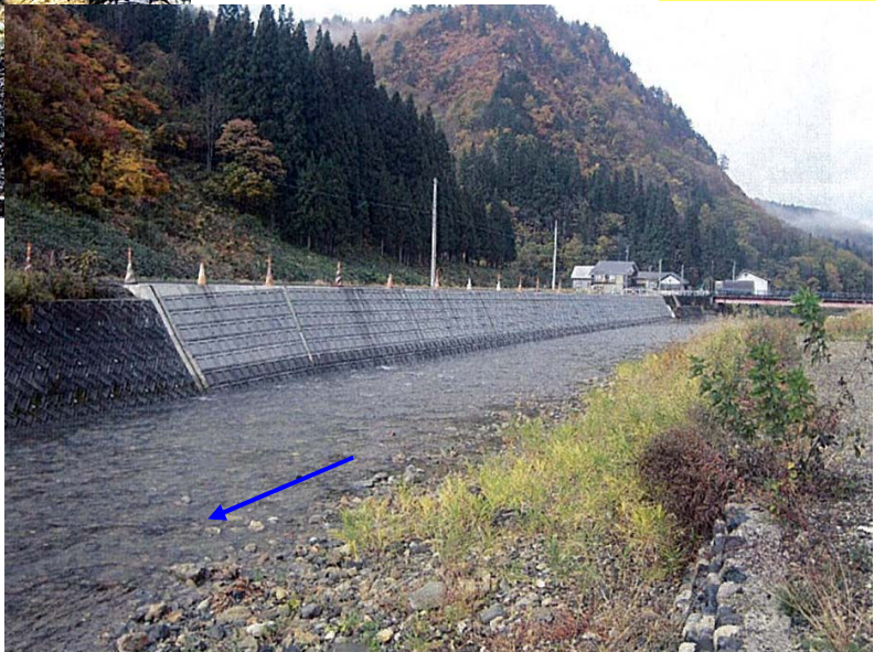
西芦沢2号工区（只見町大字塩ノ岐地内）
