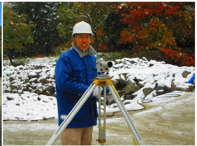
11月12日 降りしきる雪の中、床止工出来形確認 検査を行う栗山主査
