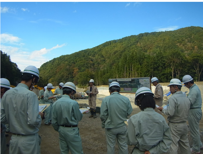
10月11日 栃木県県土整備部のみなさんが 黒谷川河川災害復旧助成事業現地視察 (概要説明する栗山主査)
