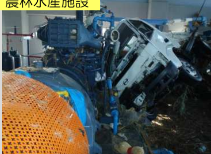
八沢排水機場の被害状況(3/29)
