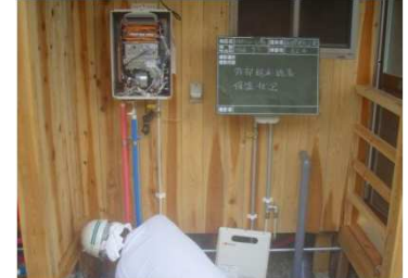
現在の給湯機を追い焚き機能付き給湯機に交換します。
