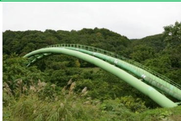
新潟・仙台ライン アーチ橋
