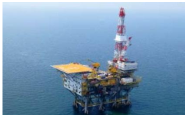
新潟県 岩船沖プラットフォーム
