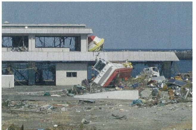
<松川浦漁港:相馬原釜漁協施設>
