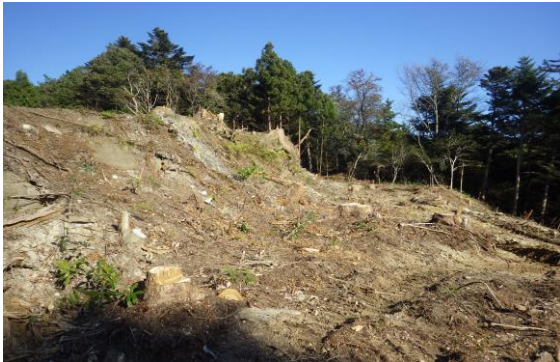
調査前の山林の木々を伐採した後の尾根付近南斜面の様子です。（浪江町大平山）
