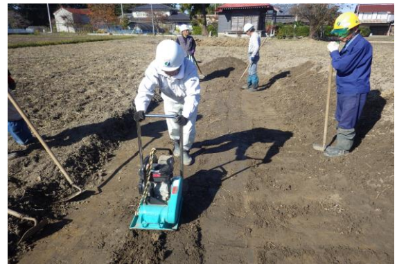
4 水田の調査では、調査終了後トレンチを専用の機械で転圧をかけながら埋め戻しました。
